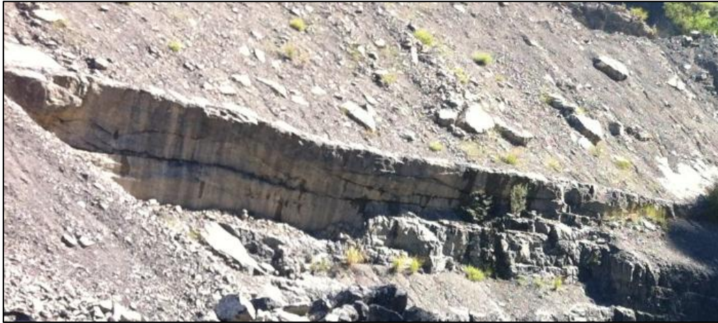
Bancs jointifs de calcaire argileux
