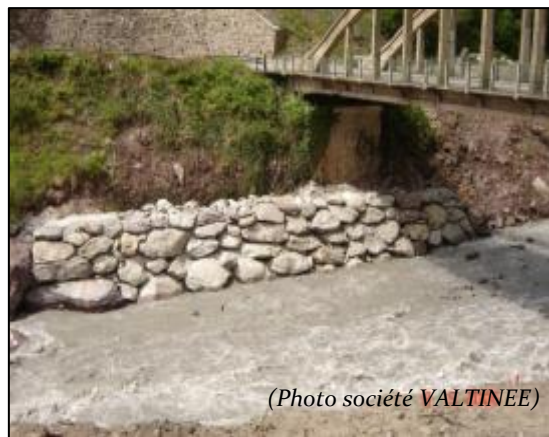
Enrochement RD30 Pont du soleil – St Sauveur s/ Tinée
