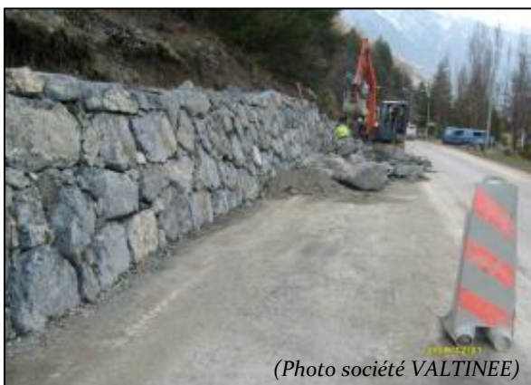
Mur en enrochement RM2205 Isola
