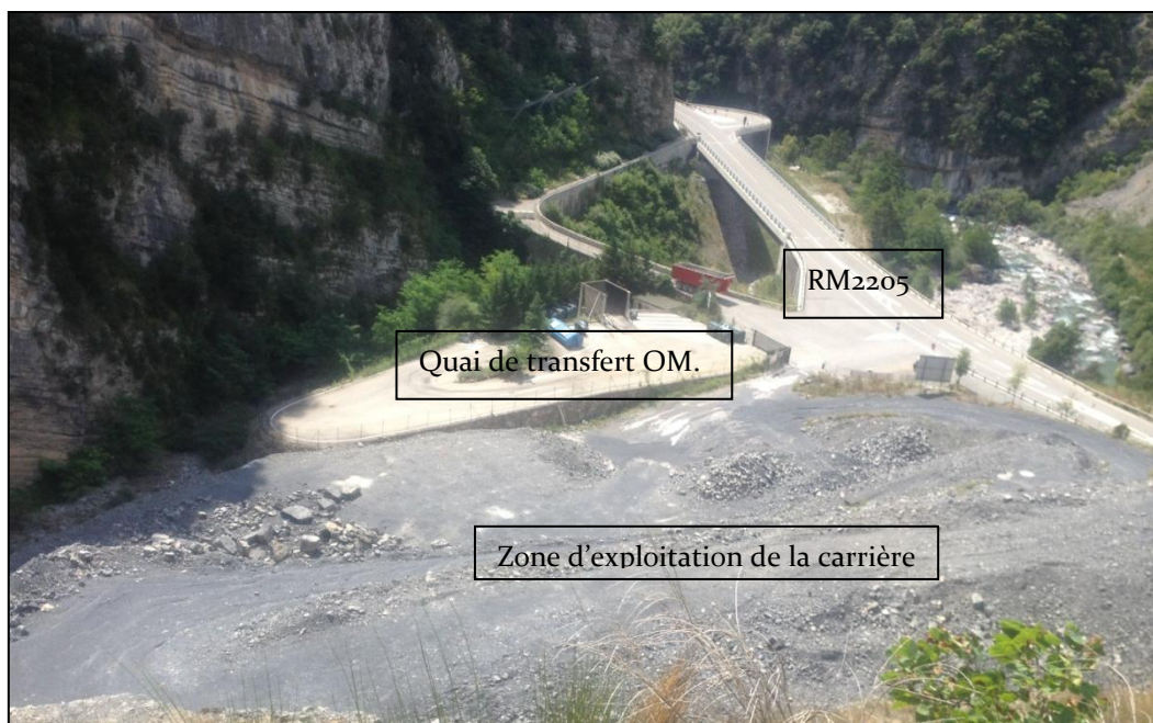
Vue sur le quai de transfert des ordures ménagères depuis la partie supérieure du front de taille (Photo SEGED août 2013)
