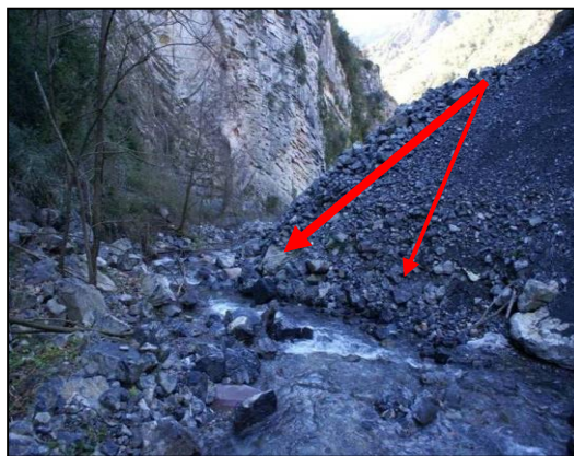
Photographie d'un glissement de matériaux de la carrière
