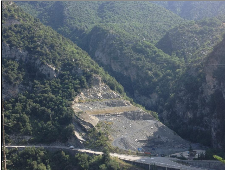
Perception depuis la route RM 59 (Photo SEGED août 2013)
